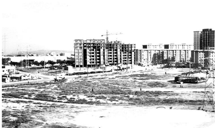
Figura 1. Barri d'Almeda en construcció. Anys 60
