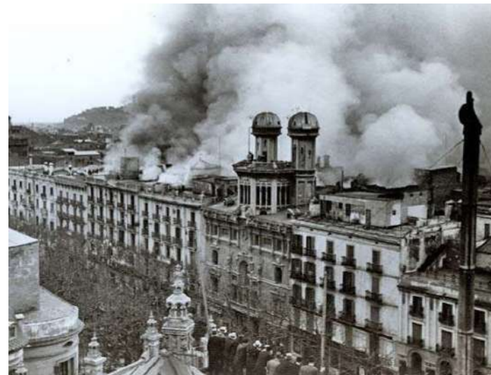
L'incendi des d'un terrat de la Rambla cantonada Santa Anna
