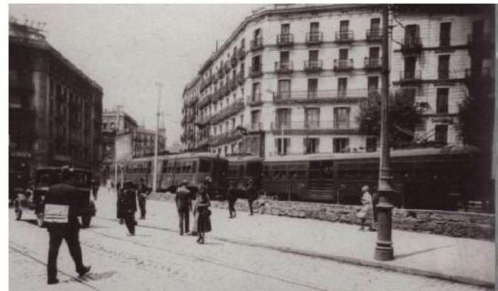
Creuament carrers Balmes, Pelai i Bergara, anys 30
