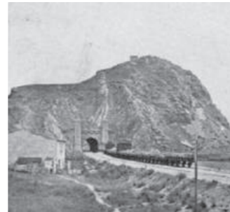
Túnel de Montgat, 1946
