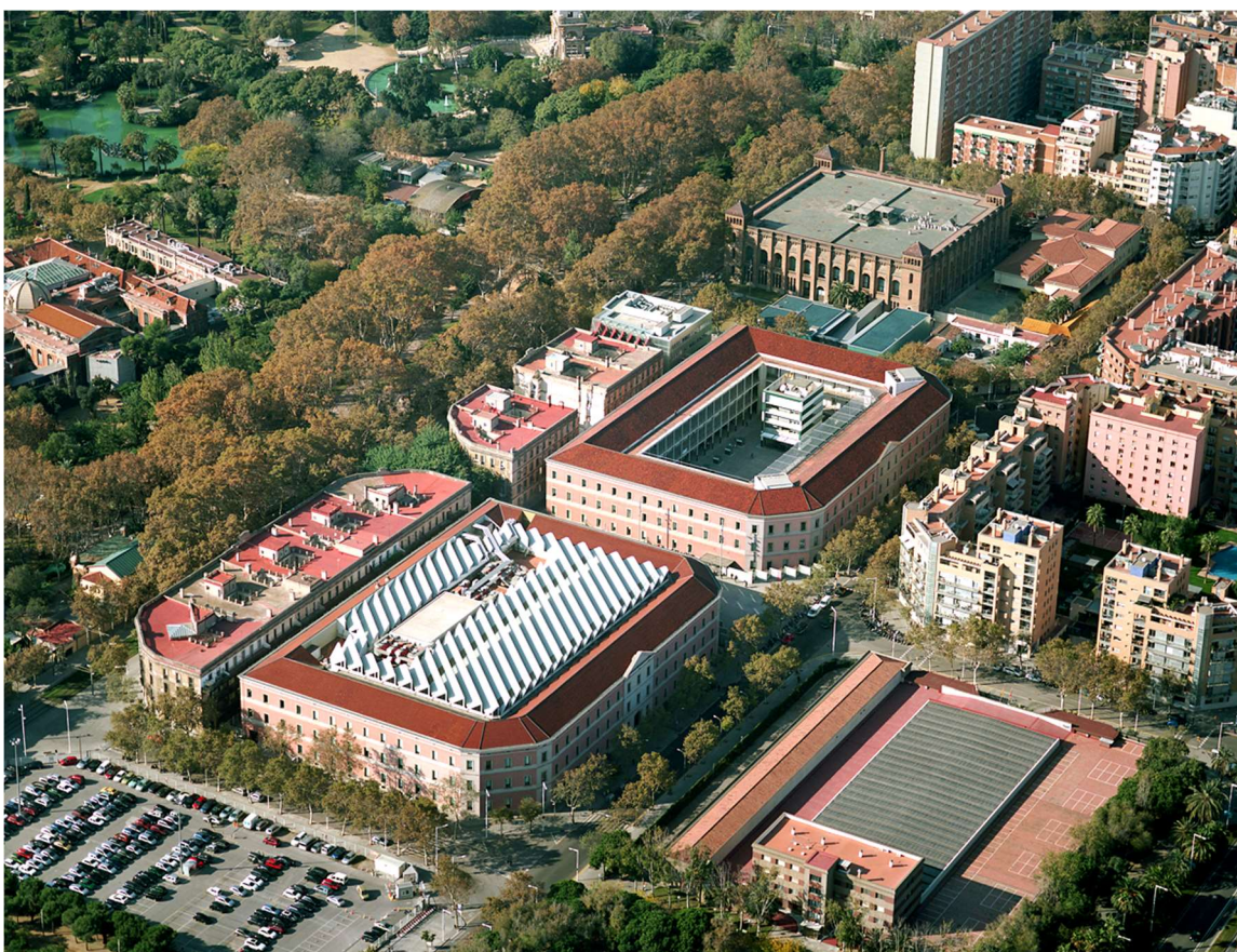
L'Antic Mercat del Peix, actualment un pàrquing, és un espai annex al campus de la Ciutadella de la UPF.
