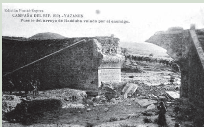
Pont de Hadduba destruït per les tropes d'Abd el-Krim.
