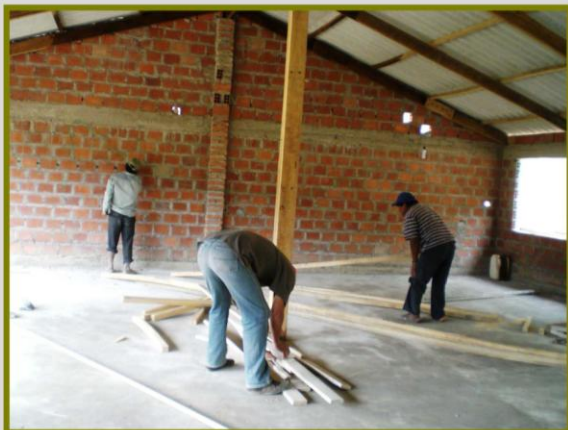
Construcció de la Granja
