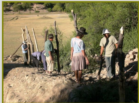
Construcció de la Granja
