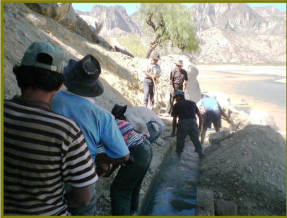
Treballs de neteja del canal de regatge
