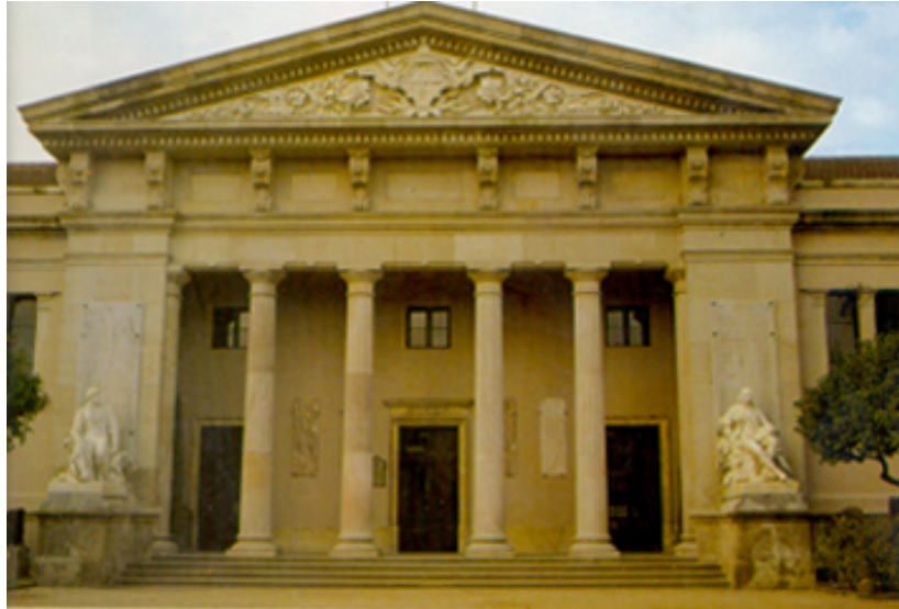
Figura 3. Fachada del Museo Martorell. La figuras en mármol de Jaume Salvador y Felix de Azara enmarcan la entrada de éste edificio de estilo neoclásico.
